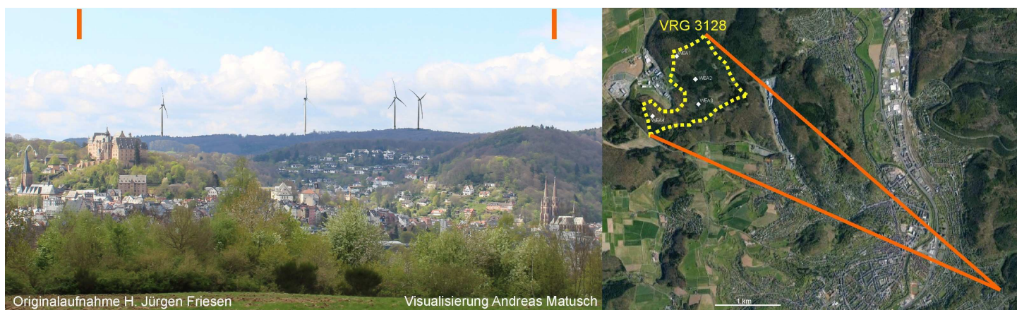
Abb. 7 Ansicht des Waldgebietes mit VRG 3128 vom Hansenhaus links, 275 m ü. NN 4,9 km südöstlich. Die orangenen Markierungen entsprechen dem in der Übersicht rechts eingezeichneten Winkelausschnitt und der Gesamtausdehnung des VRG. WEA von 236 m Höhe und 142 m Rotordurchmesser sind perspektivisch im exakten Abbildungsmaßstab abzüglich der Überdeckung durch vorgelagerte bewaldete Hügel (60, 57, 46 und 50 m) an den geplanten Standorten in 5.9, 5.5, 5.2 und 5.7 km Abstand photomontiert. Der Abbildungsmaßstab ist durch die bekannte Breite der Häuser Elsenhöhe 1-5 von 87 m in 3155 m Abstand links unterhalb WEA2 gegeben.
